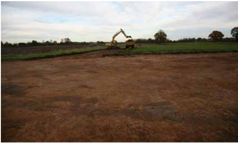
In het zuidelijke deel komt na pluggen een ijzerhoudende leemlaag tevoorschijn
